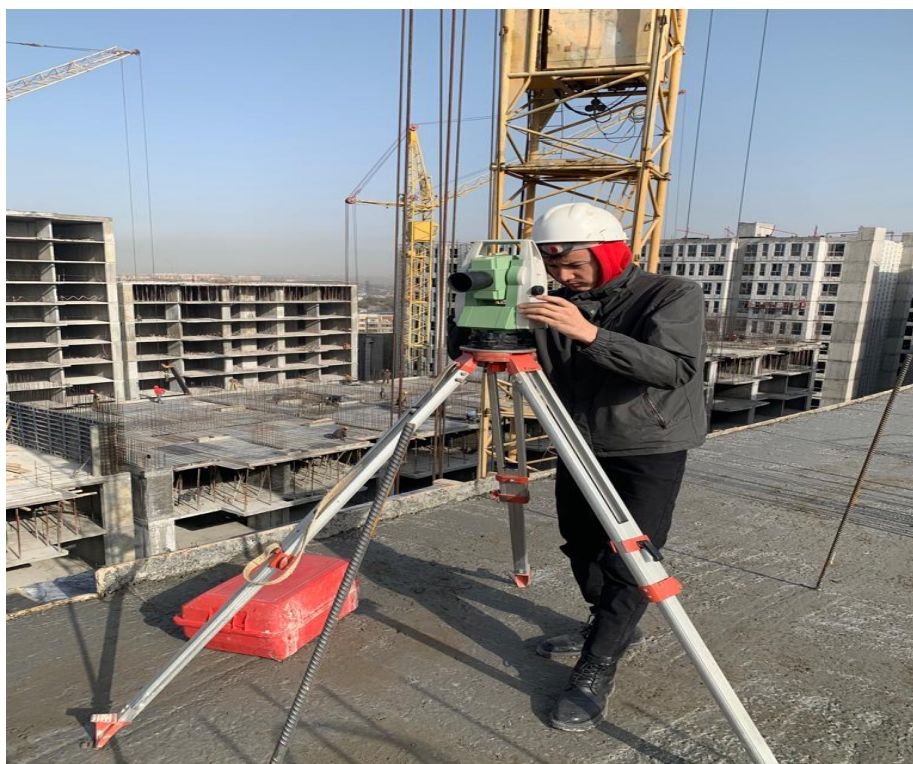
12-сурет – Нысандағы Leica TS06 тахеометрімен жұмыс
