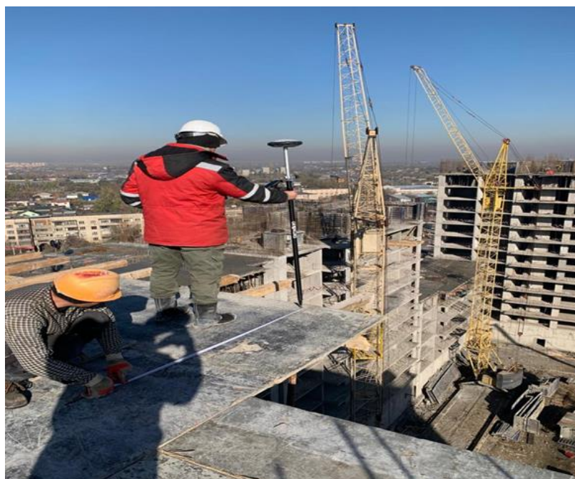
14-сурет – Spectra Geospatial SP60 GNSS қабылдағышымен жұмыс барысы
